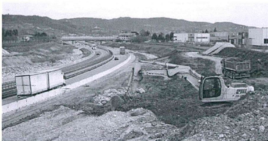
Lavori nel tratto vicentino della superstrada Pedemontana
